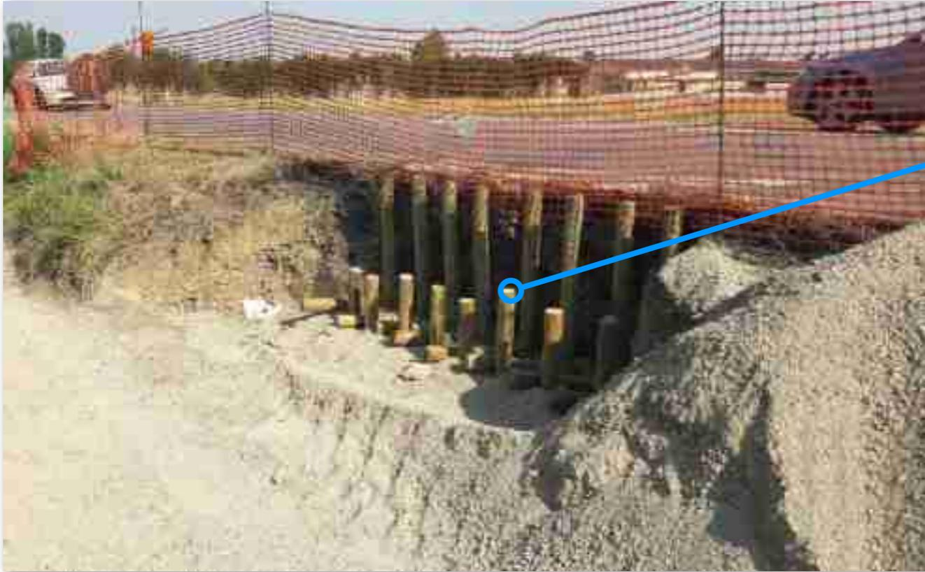
Consolidamento della banchina tramite palificata per consentire lo scavo del terreno interessato dallo sversamento senza rischi di crollo della strada
